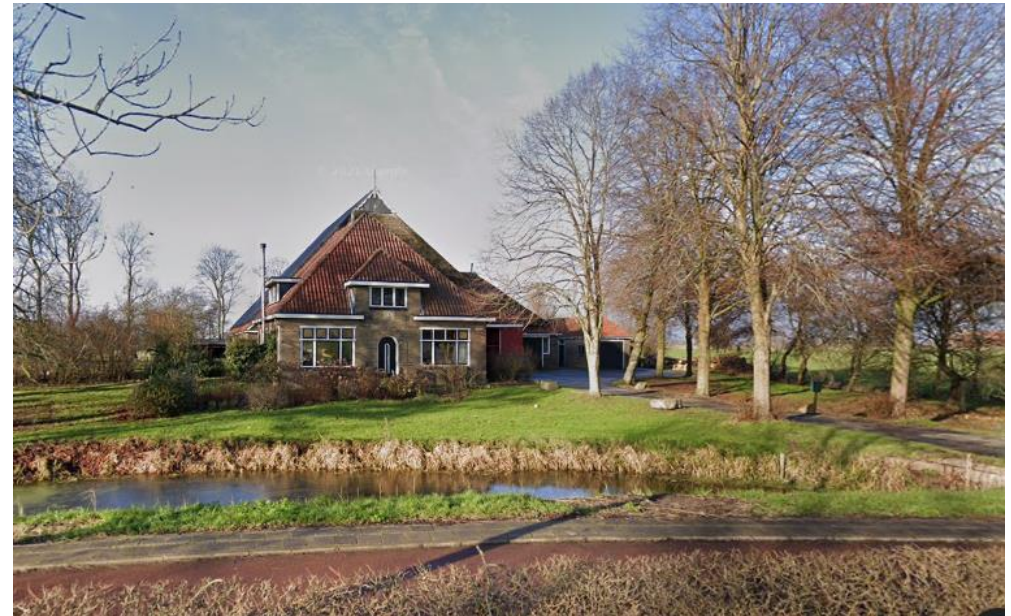
Buorren 99 moderne kop-rompboerderij, gebouwd 1932-1933
