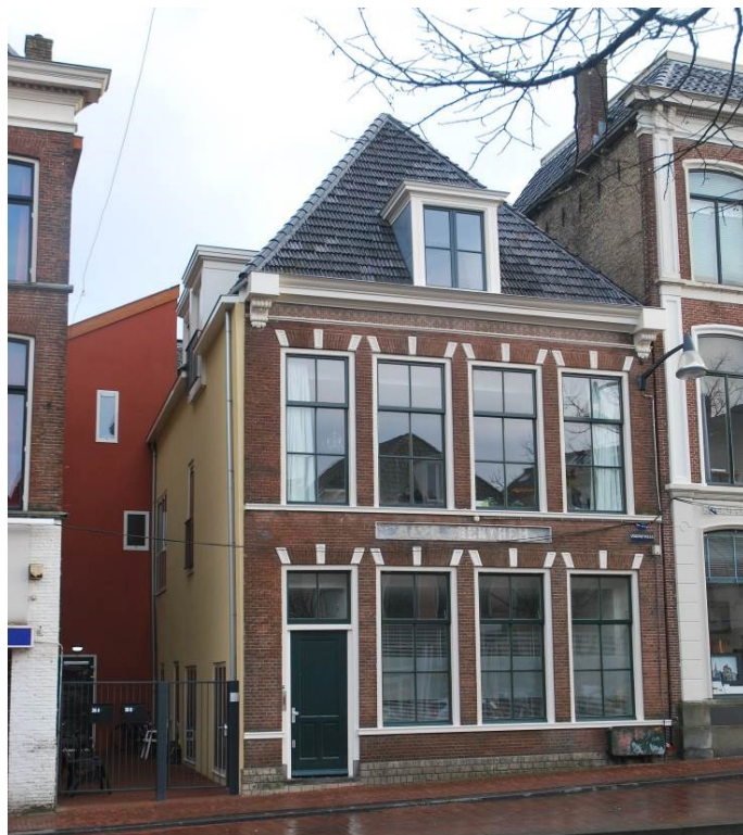
De restauratie en herbestemming van Voorstreek 36 zijn mogelijk geworden door provinciale subsidie
