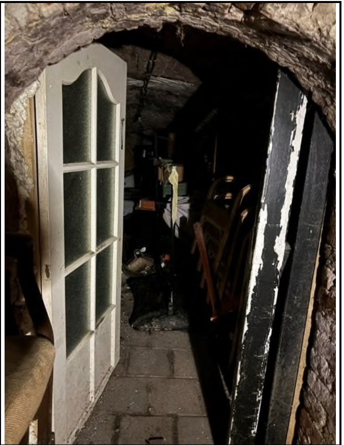
Foto 14: Deur naar de kelder.
