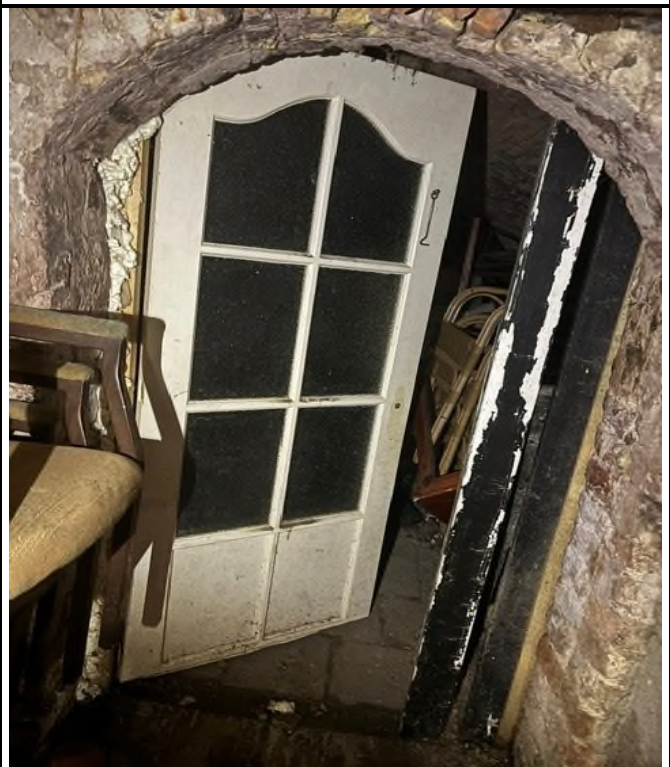
Foto 12: Deur naar de kelder.
