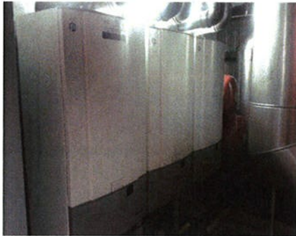
Figuur B1.7.1 Remeha CV-wandketels
