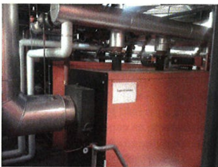
Figuur B1.7.3 Froling staande CV-ketel
