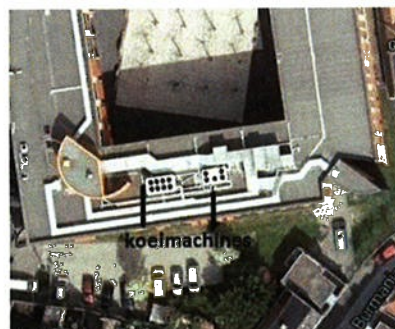
Figuur 5.2 Huidige koelmachines op dak Carré
