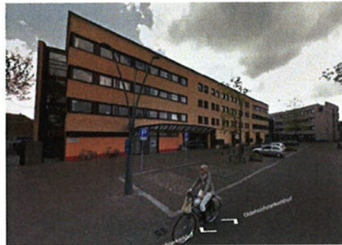
Figuur B1.1.4 Noordgevel
