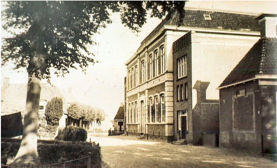
1. Historische foto van het voormalige schoolgebouw met rechts op de voorgrond de oude schoolmeesterswoning
