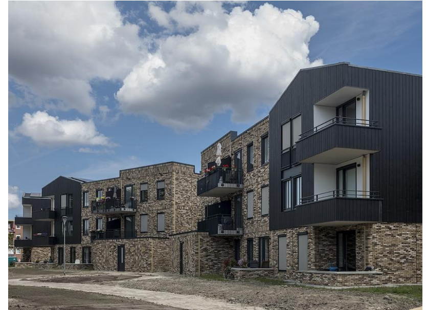
Harkenrothstraat, Appingedam Benadrukking van losse elementen en kleinschaligheid door verspringingen t.o.v. de rooilijn en door wisselingen in materialen en kleuren. NB: de platte daken gelden niet als referentie
