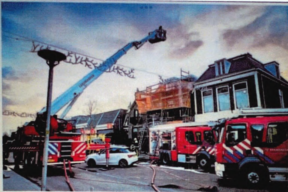
De brand in het dak van de bovenwoning aan de Schrans was snel onder controle.
