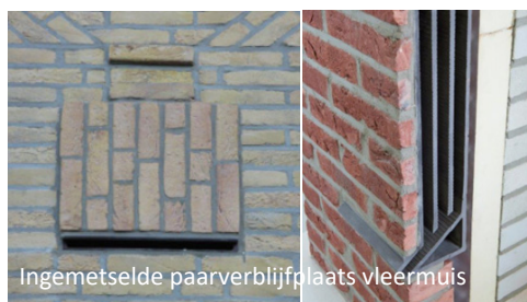
Vleermuisverblijfplaatsen ingemetseld in de schoorsteen
