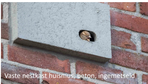
Vaste nestkast huismus, beton, ingemetseld
