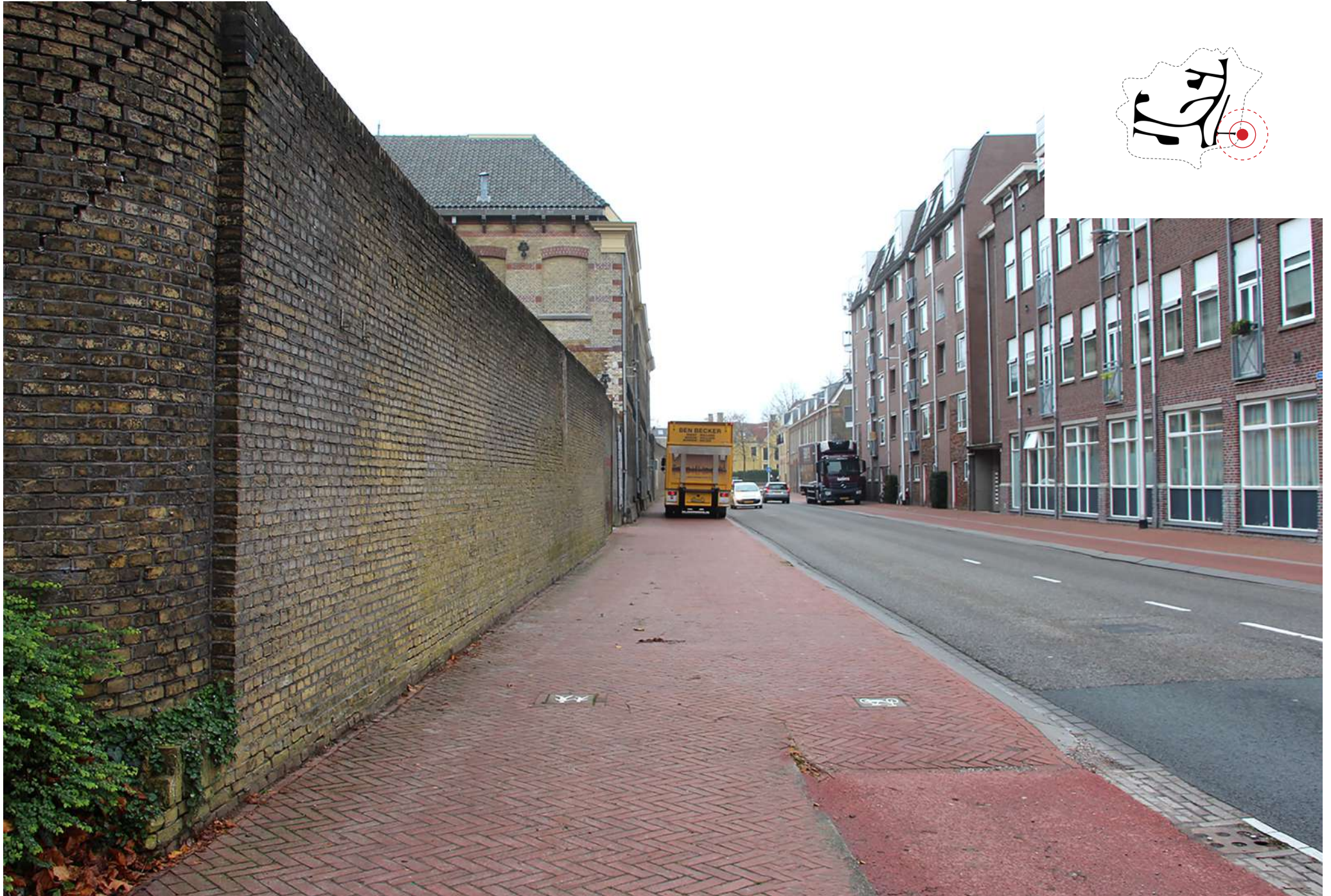
Verharding van gevel tot gevel
