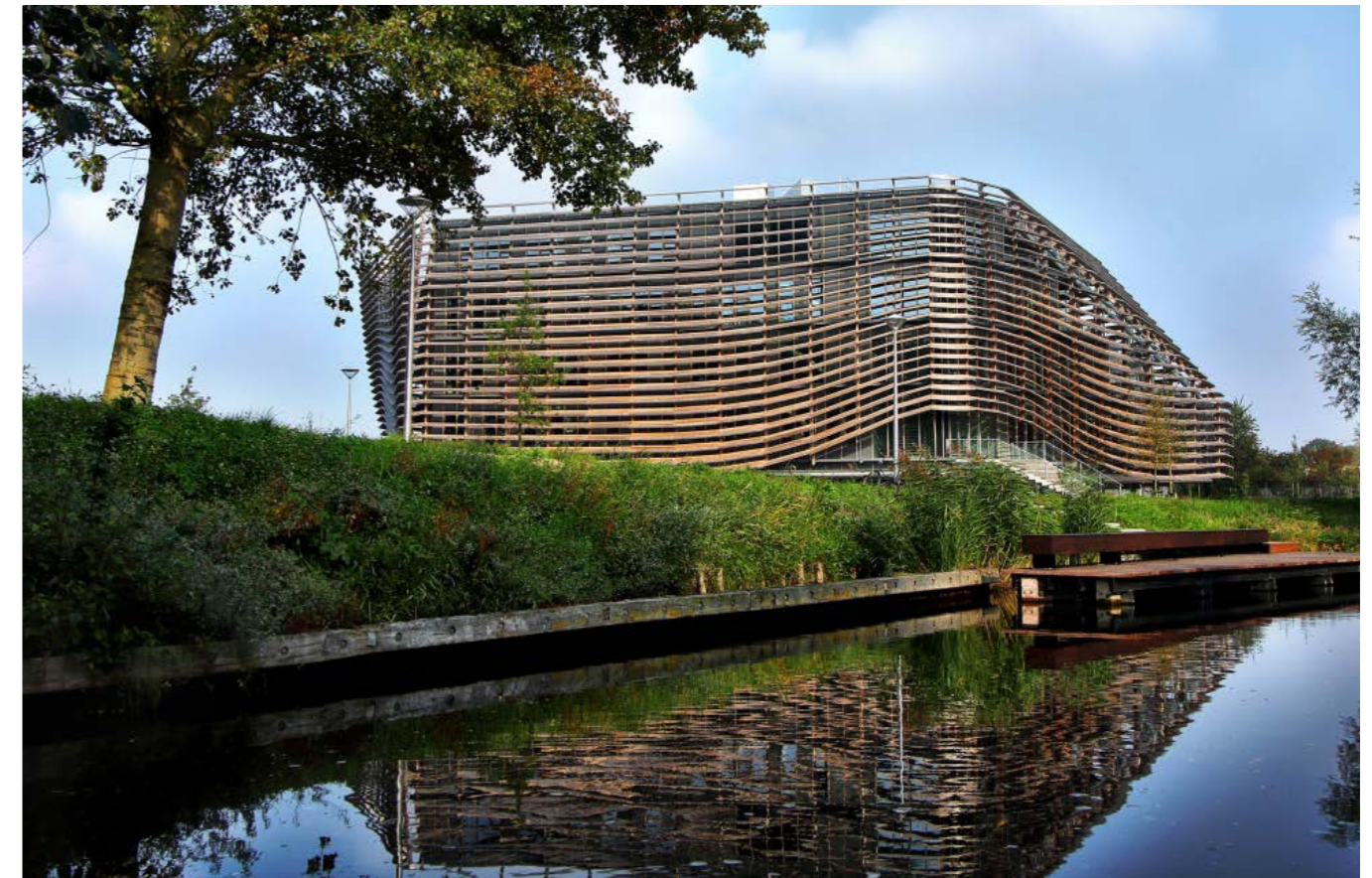
De Watercampus en aangesloten bedrijven zijn belangrijke partners in de verdere ontwikkeling van Leeuwarden. Bron: Circulair Friesland
