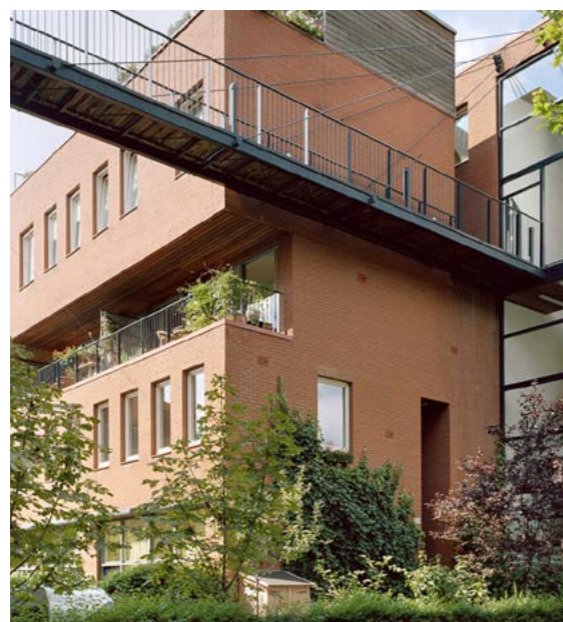
Stereotomisch: hier is het uitgangspunt juist massa. Uit deze massa worden vervolgens vormen weggesneden, wat leidt tot een zeer sculpturale en stevige architectuur. De lichte loopbrug geeft een mooi contrast. KCAP - GWL
