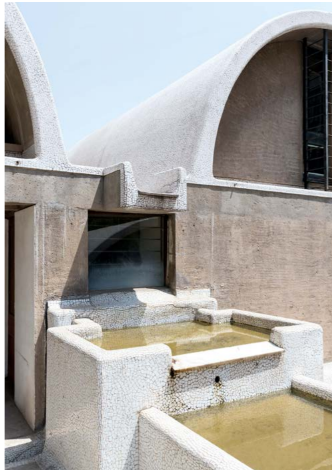
Zichtbaarheid water in goten
