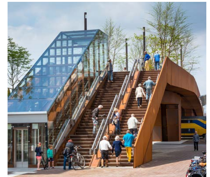
Met een lift of (mechanisch ondersteunde) fietsgoot kan de Passerelle alsnog gebruikt worden door fietsers en rolstoelen. Paleisbrug, Den Bosch
