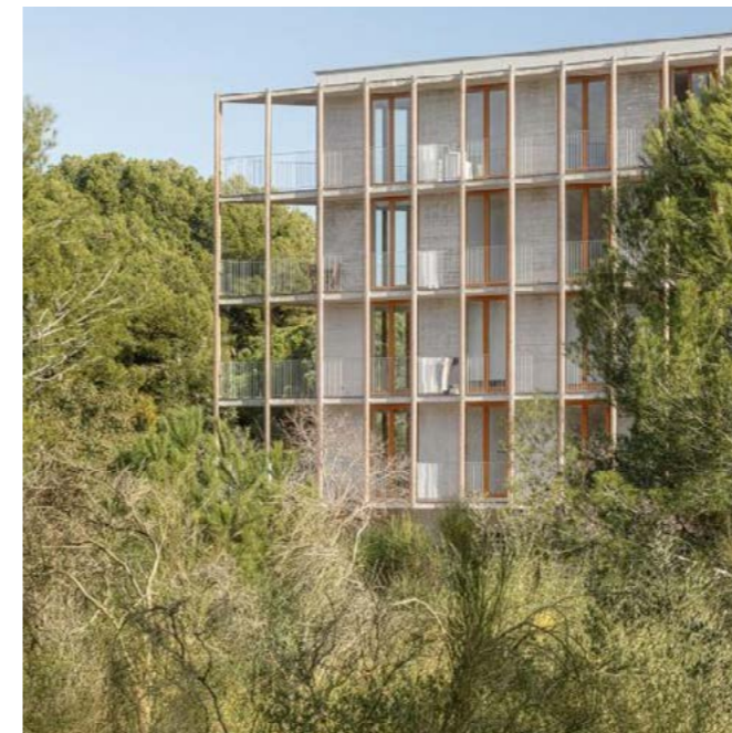
De bebouwing vormt een neutrale begrenzing van het weelderige park. Harquitectes - Social housing 1737
