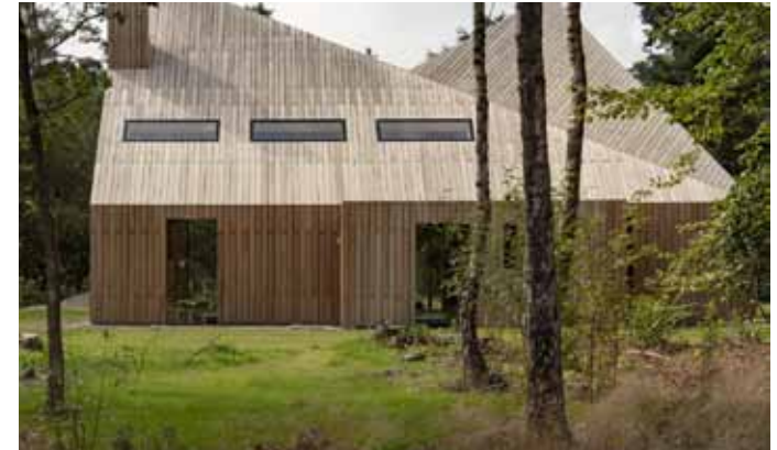
Referentie, gevel en dak van hout, lijnenspel van plank lengtes
