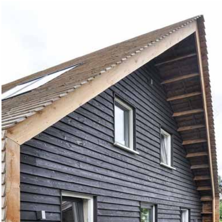
Referentie, houten woning, gevel, dak en kozijnen en houtskelet met houtwol isolatie zodat veel CO 2 wordt opgeslagen
