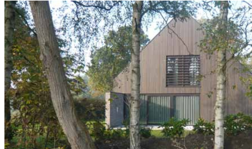
Referentie, dwarskap, lage goot, kleur gevel en kozijnen in dezelfde tint, metselwerk ondergeschikt
