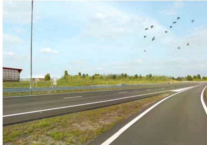
1 zicht vanaf de oprit naar vd Valk, geluidswal en Unia
