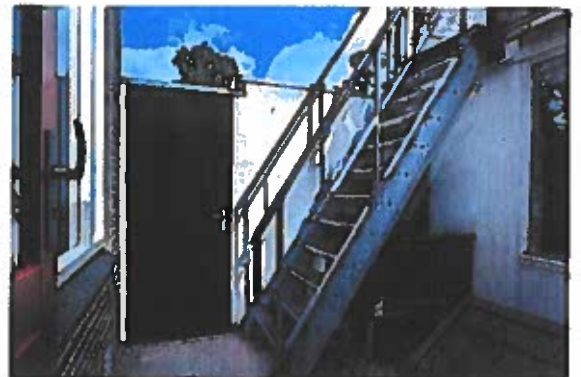
Buitendeur met toegang naar binnenplaatsje en de verdieping
