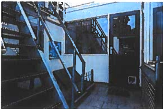
Toegang naar de verdieping via binnenplaatsje
