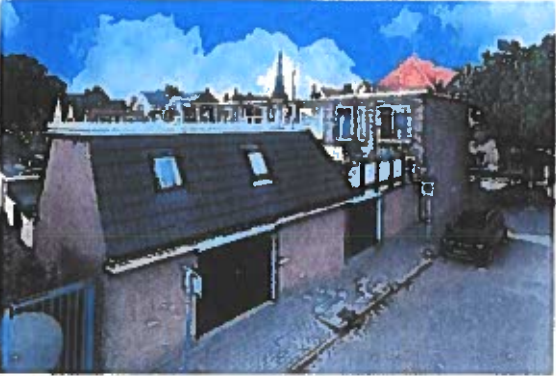
Garage/berging gezien vanaf de zijkant
