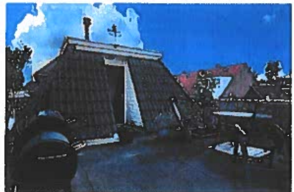
Dakterras op garage/berging met toegangsdeur naar de verblijfsruimte
