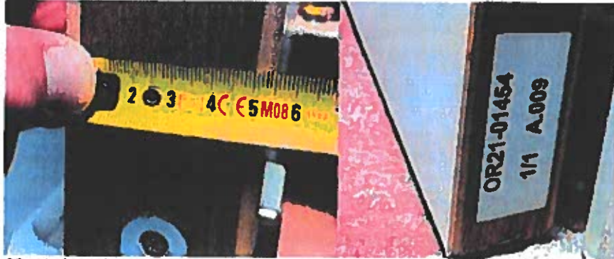
60 min brandwerende deur bufferbewaarpplaats 1 van fabrikant Van Vuuren Groep B.V. type deur OR21-01454 1/1 A.009
