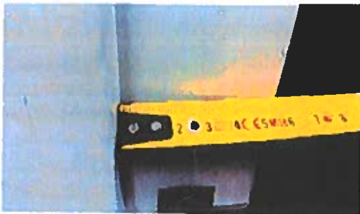
Dagmaat deur/ kozijn bufferbewaarpplaats 1 bedraagt 57 mm
