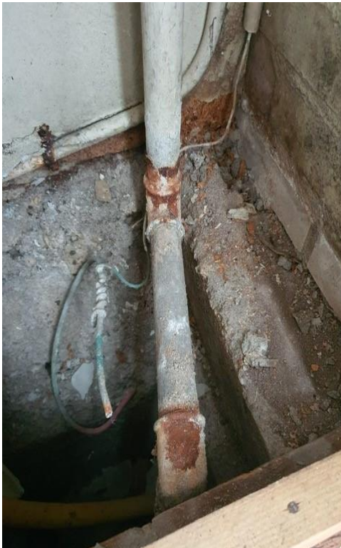
Figuur 2: aangetaste stalen koppelstukken en een deel van de stalen gasleiding, het leidingwerk begint bij de toegang van de woning en loopt onder de vloer door tot in de meterkast.
